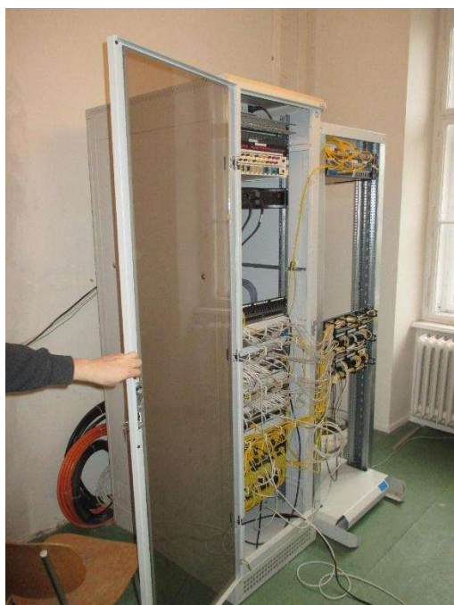
Obr. Datové rozvaděče MDF a IDF v 1. NP
